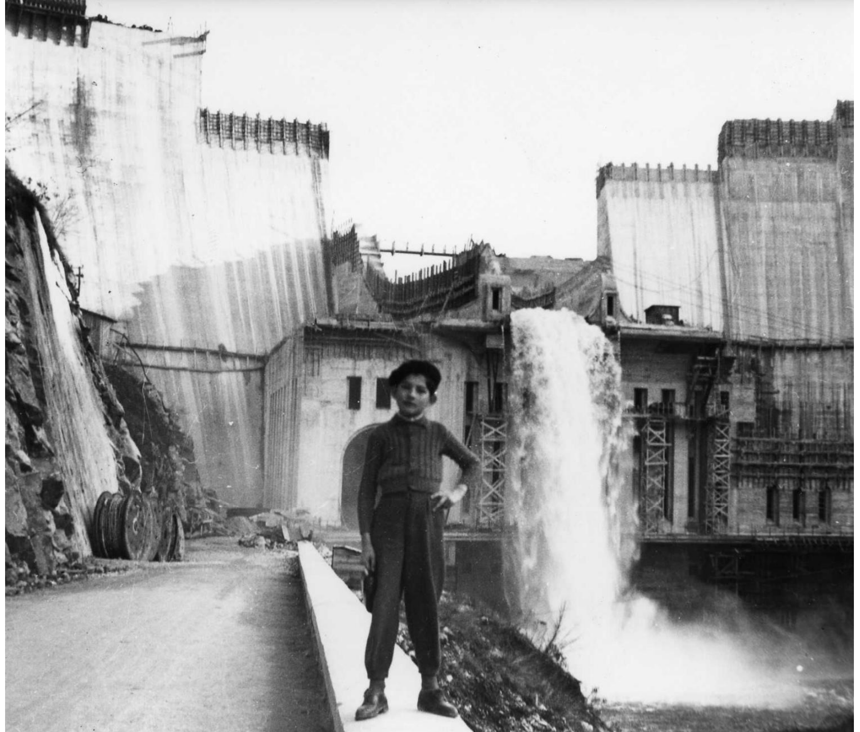
AD Cantal 40 Fi 685 – Reproduction d'une photographie : enfant prenant la pose devant le barrage de Saint- Etienne-Cantalès en cours de construction (1942-1943)
