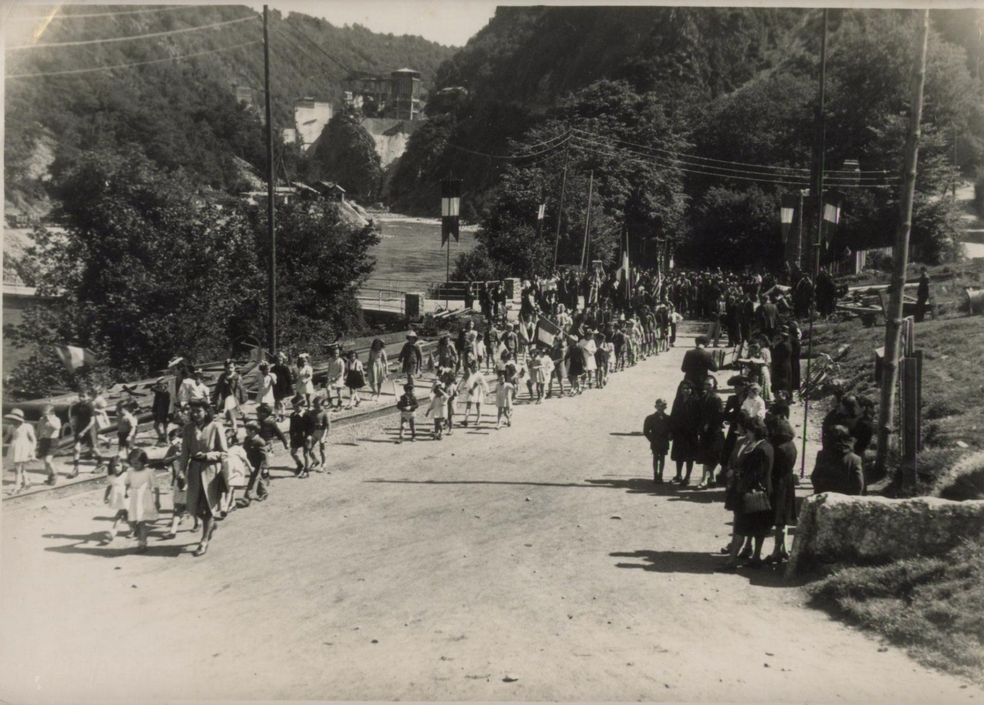
Rassemblement à Aynes, commune de Chalvignac, près du pont sur la Dordogne ; on aperçoit en arrière- plan le barrage de l'Aigle en cours de construction (vers 1942).
